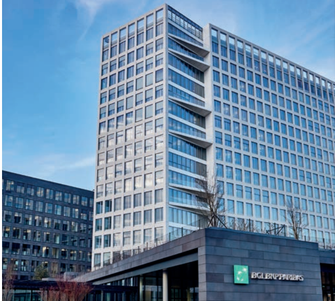
BGL BNP Paribas, Lüksemburg, Lüksemburg ClimaGuard® Dry | Çift cidarlı cephe, yoğuşma önleyici kaplama dış yüzeyde Mimar: M3 Architectes | Fotoğraf: © Frank Weber
