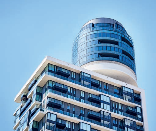
Henninger Turm, Frankfurt/M, Almanya SunGuard® RD 60 | Radar refleksiyon azaltıcı ve solar kontrol cam Mimar: Meixner Schlüter Wendt (Frankfurt/M.) | Fotoğraf: © Frank Weber
