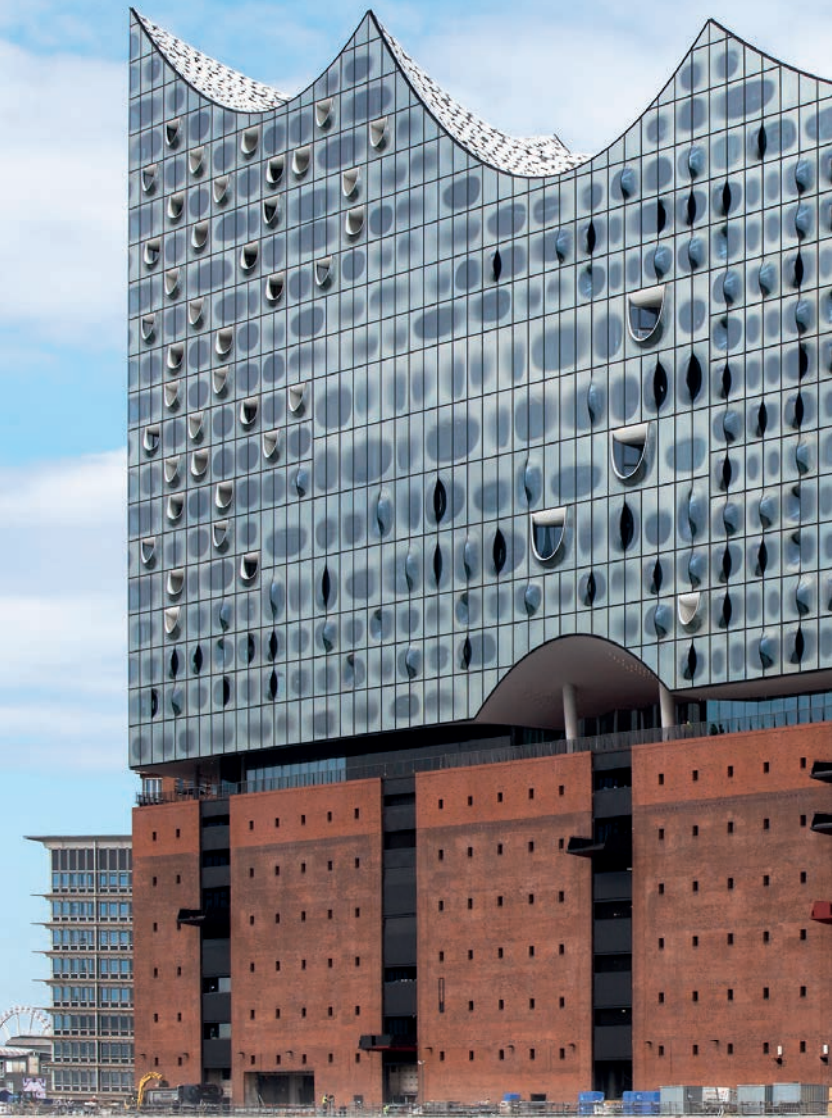
Elbphilharmonie Hamburg, Hamburg, Almanya SunGuard® HD Light Blue 52 | Yerçekimi ile 3 boyutlu bombelenmiş, seramik baskılı, lamineli yalıtım camı Mimar: Herzog & De Meuron, Basel | Fotoğraf: © Cordelia Ewerth
