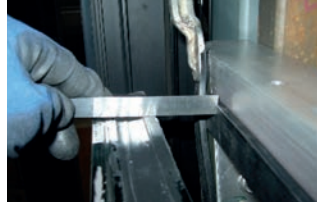
Sapma dZ: Çift camın büküm öncesi alt konstrüksiyona itilmesi
